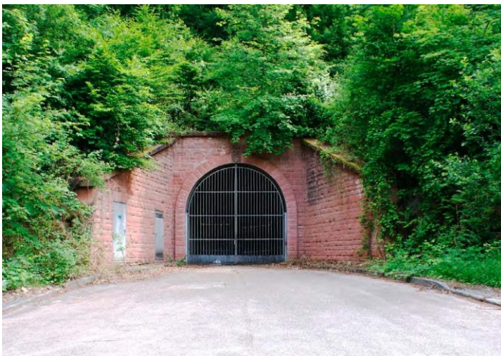
Abbildung 1: Eingang zur Würmtalrampe an der Würmtalstraße bei Würm
